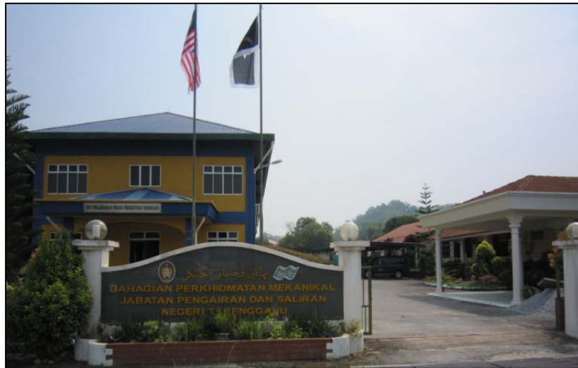
BANGUNAN BAHAGIAN PERKHIDMATAN MEKANIKAL & ELEKTRIKAL. JPS. TERENGGANU
