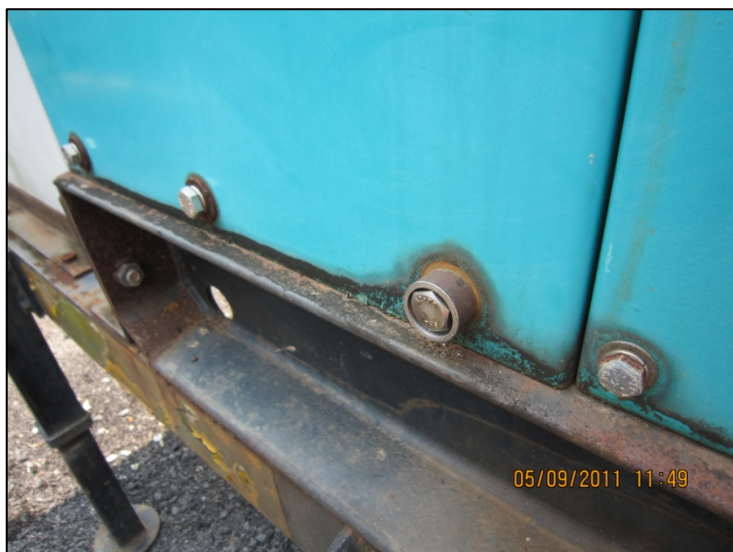
PEMASANGAN SAFETY WASHER PADA GENERATOR
