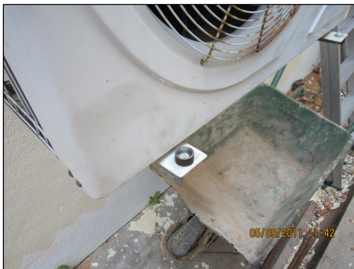
PEMASANGAN SAFETY WASHER PADA AIR CONDITION - OUTDOOR
